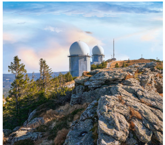
Auf dem Großen Arber im Bayerischen Wald betreibt die Bundeswehr eine Radaranlage.
