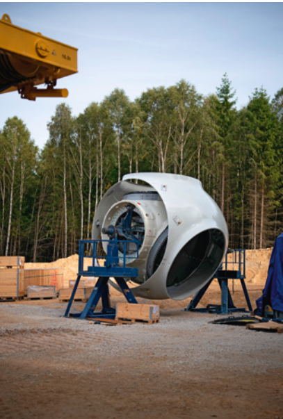
Großkomponenten für den Windpark Wiebelsheim: Turmteile (links), Gondel (oben rechts) und Nabe (unten rechts) werden vor dem Aufbau im Wald zwischengelagert.
